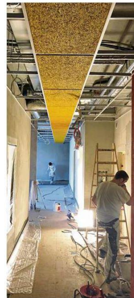
Der Durchgang zu den Umkleidekabinen hat eine helle Decke.
