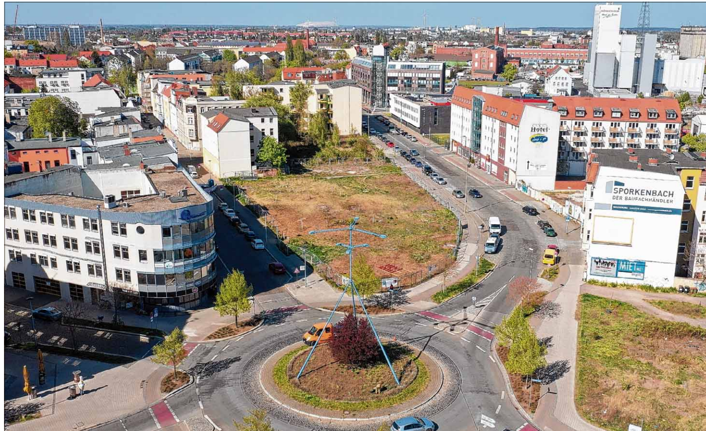
Auf der Brachfläche am Wittenberger Platz haben die ersten Baggerarbeiten für den Bau eines neuen Wohn- und Geschäftshauses mittlerweile begonnen. Voraussichtlich Anfang 2022 sollen die ersten Mieter einziehen können. Foto: Eroll Popova
